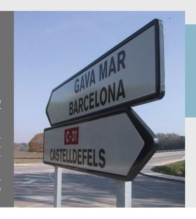
un refuerzo perimetral de  $\pm$  25 mm, posteriormente se efectúa el tratamiento de las piezas mediante un desengrasado y pintado en polvo termoendurecible a base de resina de poliéster con un recubrimiento de 50-60  $\mu$  y polimerización en horno a 200°, tanto la parte trasera como la delantera de los colores correspondientes, por último se aplicará la lámina retrorreflectante RA1, RA2 o RA3, y rotulada con las formas y símbolos correspondientes según norma 8.1 IC.
